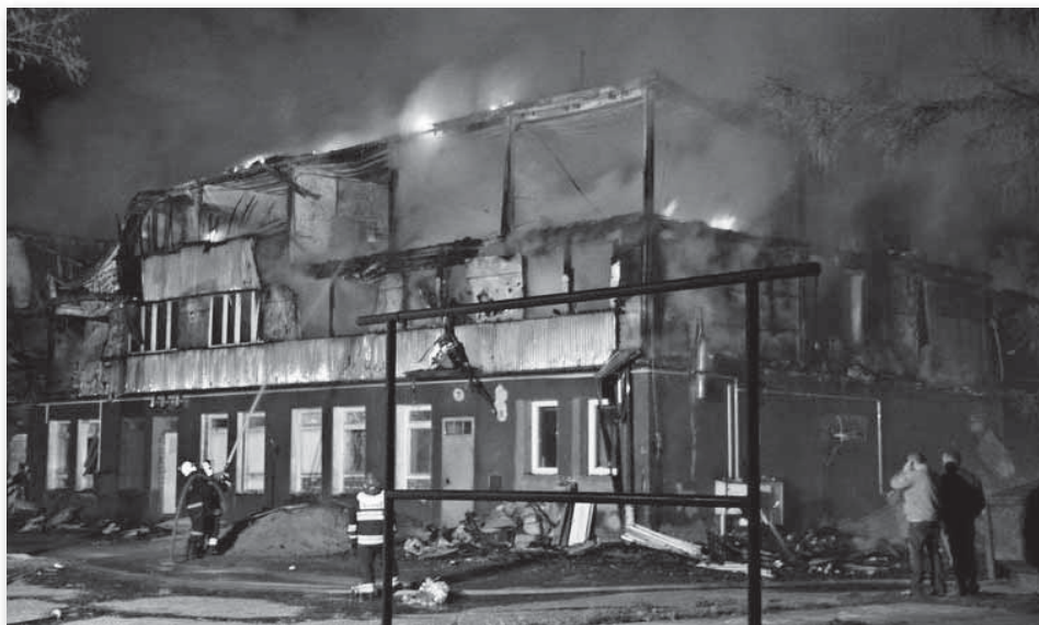
Tragiczny pożar hotelu socjalnego | Kamień Pomorski, 04.2009 r.
